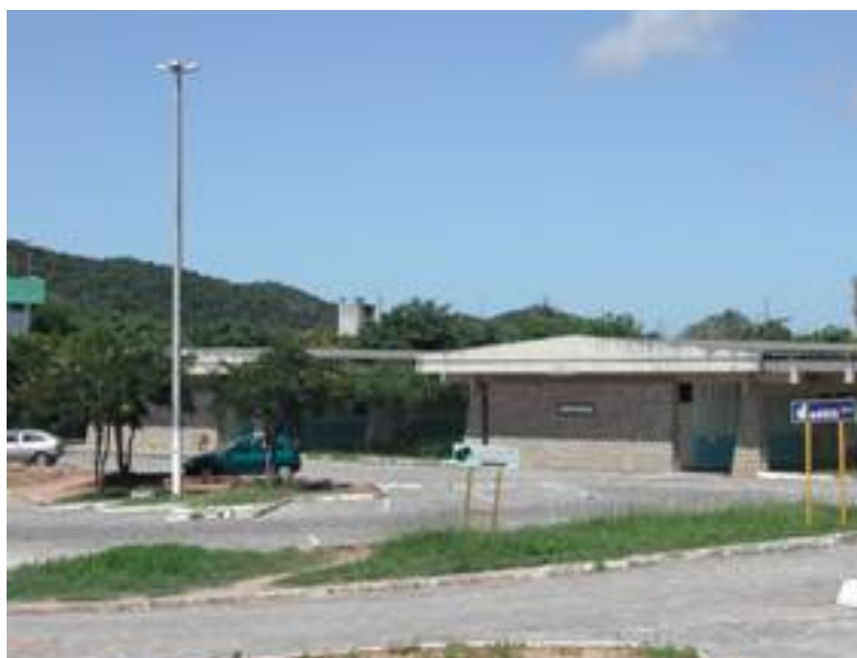
Fig. 30. Foto do Setor de Aulas Teóricas III.
