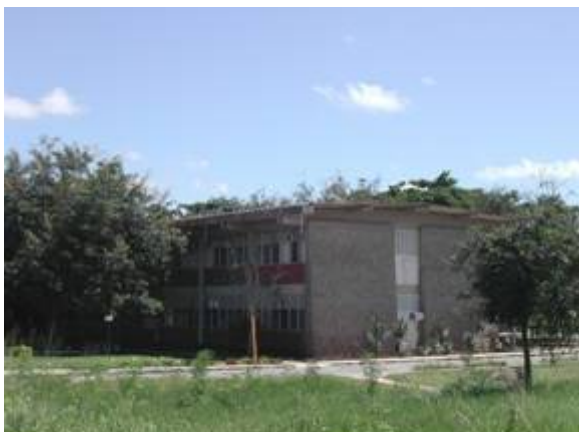
Fig. 41. Foto do Centro de Tecnologia (CT).
