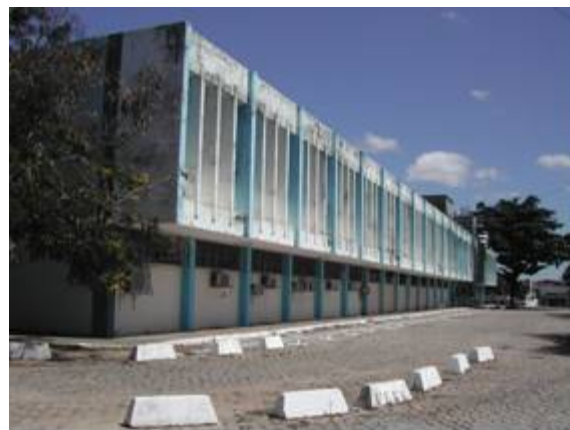
Fig. 27. Foto atual do Prédio da Escola de Engenharia em 2005.
